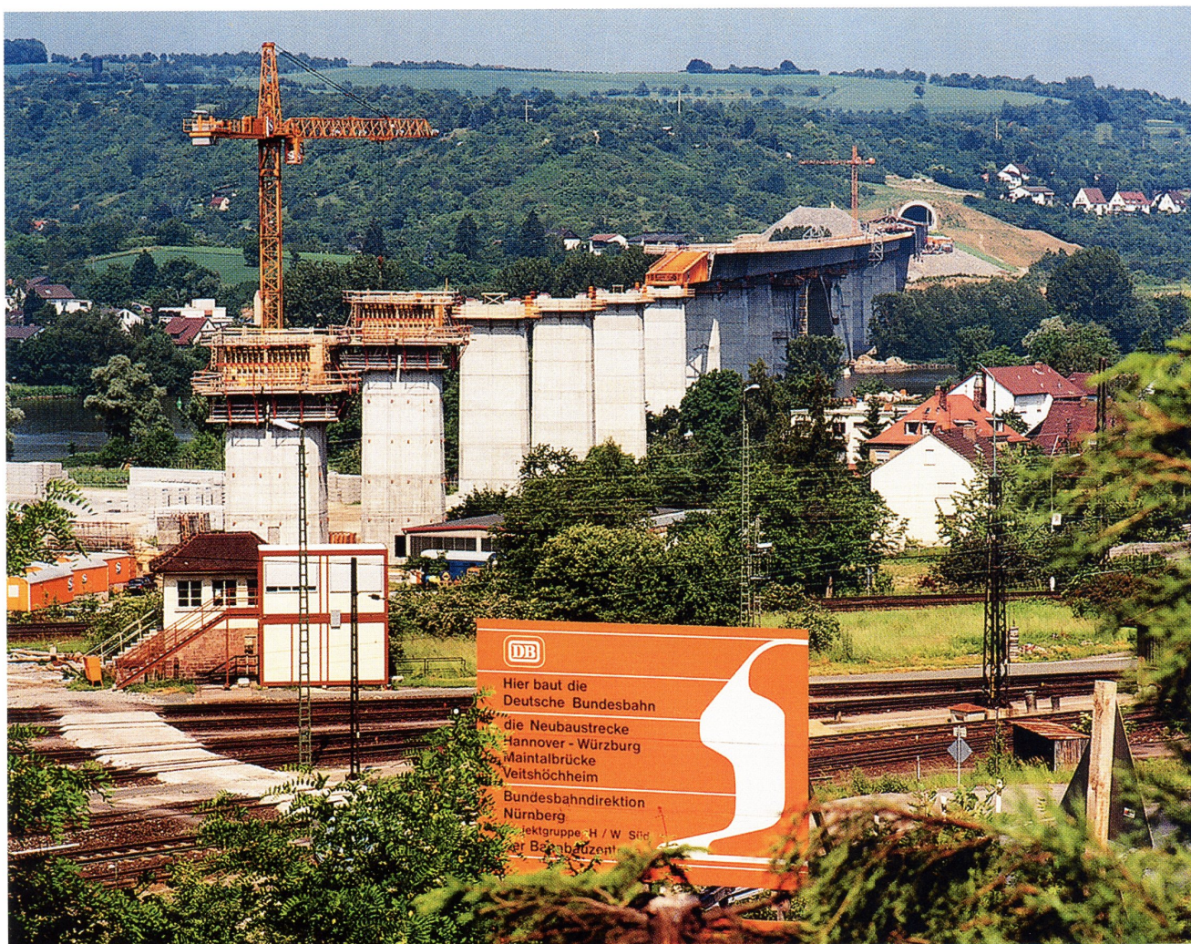
▲ Строительные работы на железнодорожной линии Ганновер – Вюрцбург. Возведение моста через Майн у Файтсхейма.
